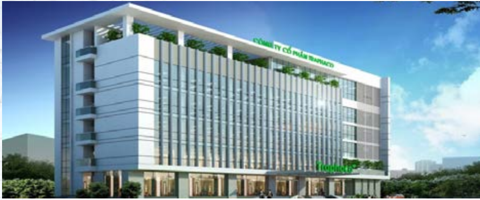
Nhà máy dược phẩm Traphaco/ Traphaco Factory ▼
